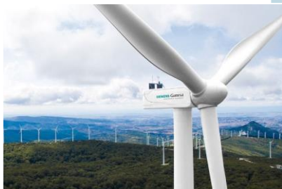
Parque eólico onshore
