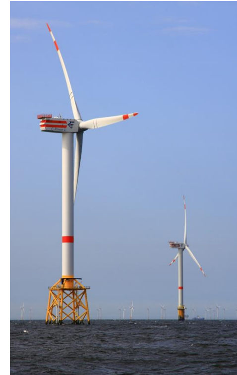
Ejemplo de un aerogenerador offshore
