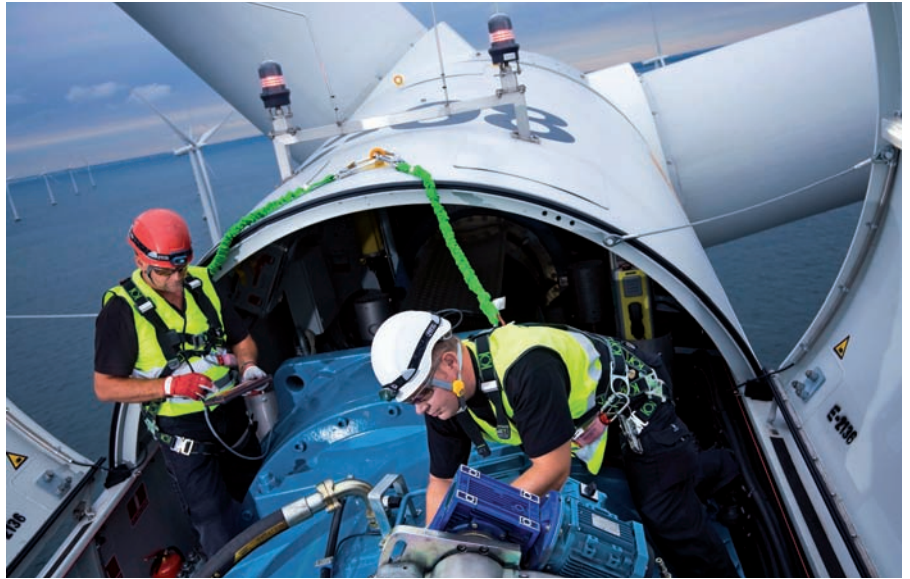
Reparación de un aerogenerador marino.
