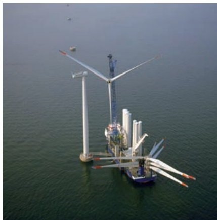
Montaje de palas en alta mar.
