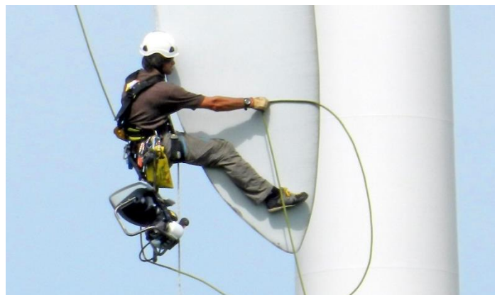
Figura 6: Inspección con cuerdas
