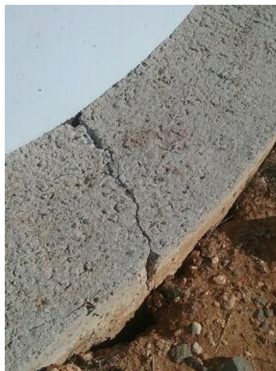
Figura 23: Daños en cimentación.
