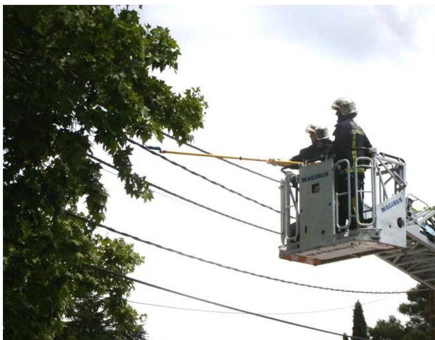
Poda de árboles para evitar contacto de las ramas con la LAT.
