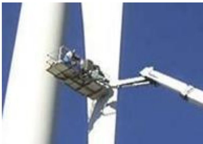
Figura 9: Inspección con cesta
