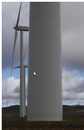
Figura 10: Torre inclinada.
