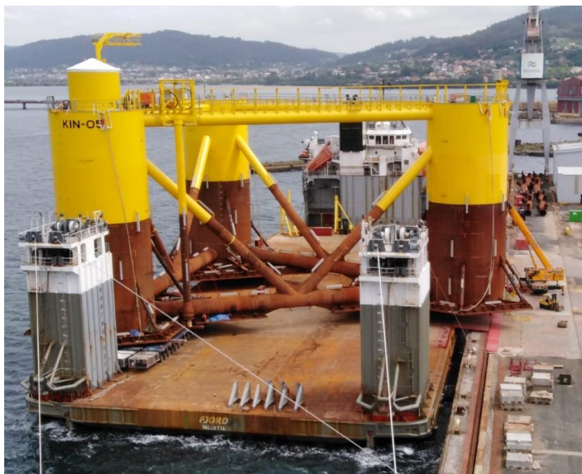
Figura 20: Construcción de una plataforma flotante en el Astillero de Fene, Ferrol 6 .
