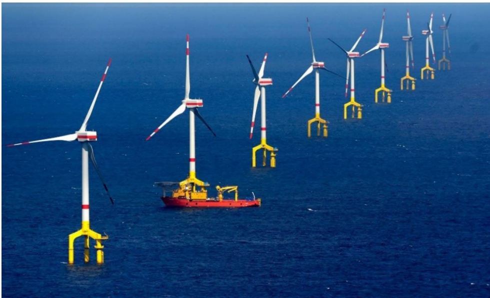
Figura 2: Aerogeneradores con cimentación fija tripile (Fuente: Fabian Bimmer/Reuters).
