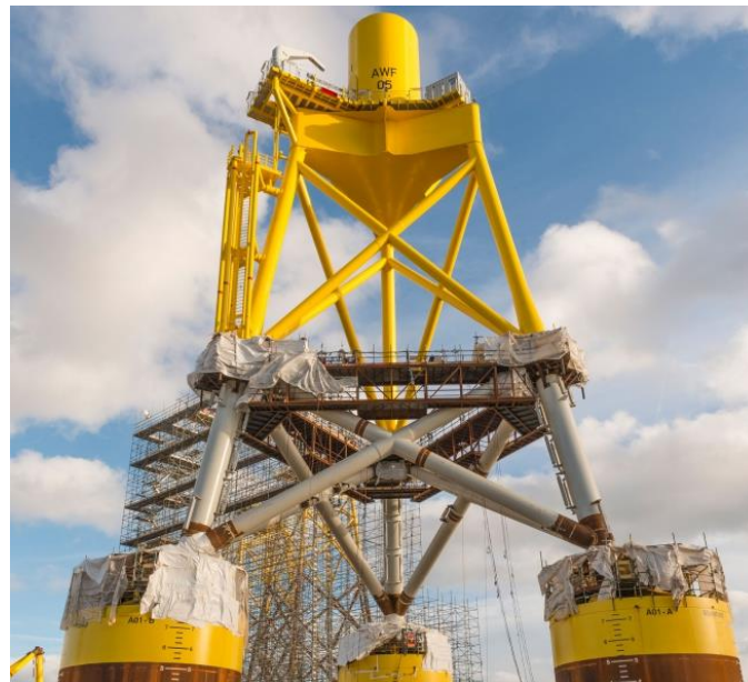
Figura 4: Cimentación fija con suction buckets (Fuente: Smulders).
