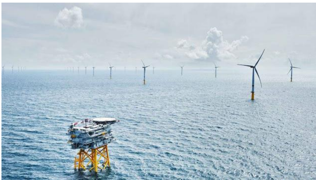
Figura 12: Disposición de un parque eólico marino, en la cual se aprecia la subestación en primer plano y la disposición en filas de los aerogeneradores. 2
