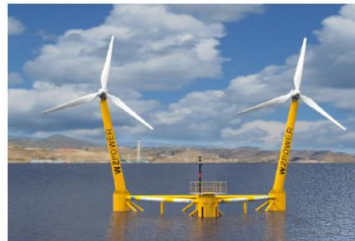
ENEROCEAN - W2POWER. Multiplataforma de Eólica Marina Flotante. Prototipo 1:6 ensayado en PLOCAN (2019)
