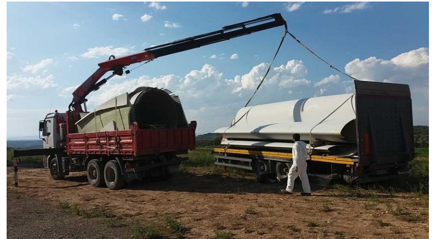
Corte in-situ de las palas en trozos. Fuente bcircular.
