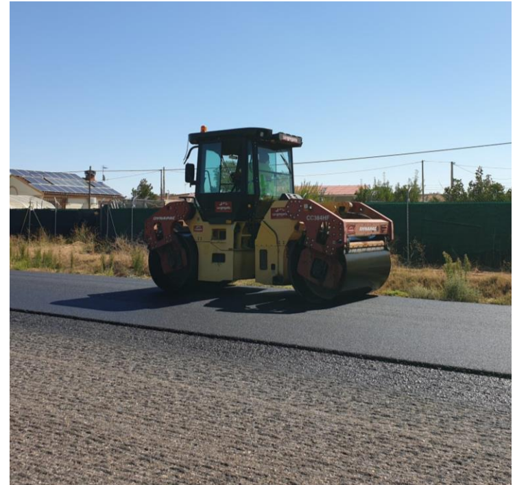
Asfalto fabricado incluyendo fibra de vidrio reciclada de palas de aerogeneradores. Fuente Proyecto Life Refibre, 2020.
