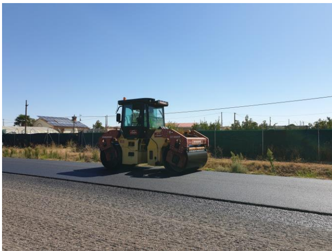
Figura 24: Asfalto fabricado incluyendo fibra de vidrio reciclada de palas de aerogeneradores (Life Refibre, 2020).
