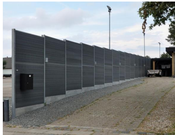
Figura 25: Barreras acústicas fabricadas a partir de palas recicladas (Fuente: Miljøskærm).
