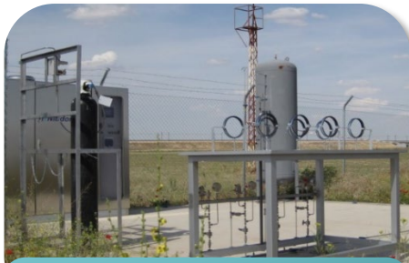
Estación de repostaje de UAV para Boeing, 2009 1Nm 3 /h – compression 350 bar
