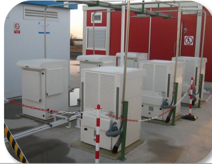
ITC-Canarias. 30 kW, 6 pilas de combustible, 2007
