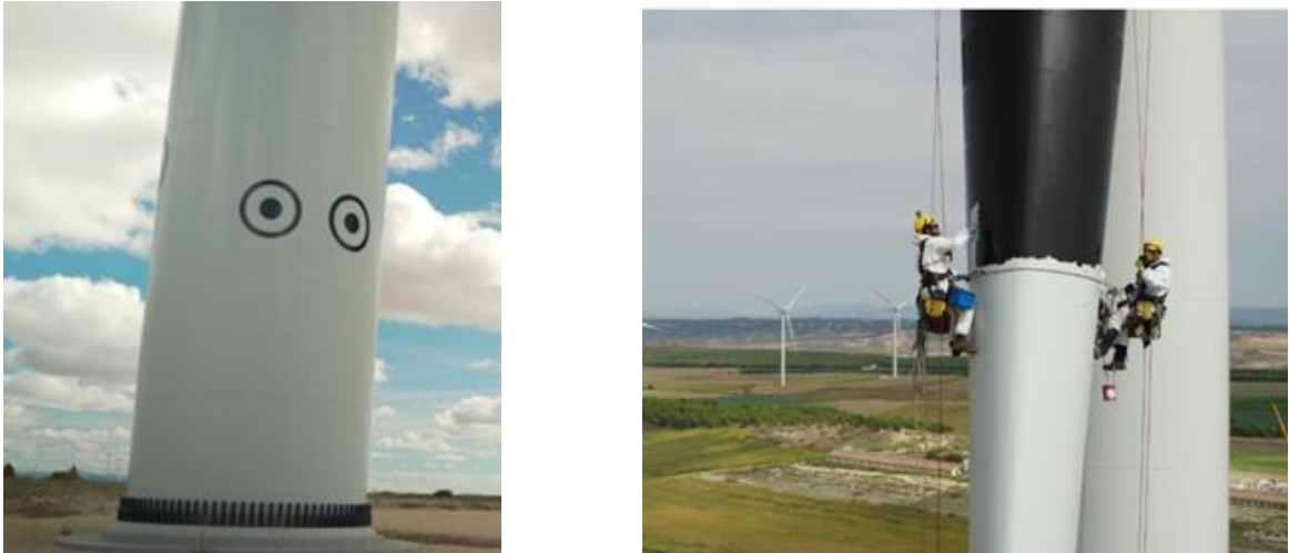
Figura 1: Vinilado de torre de aerogenerador con ojos (izquierda) y pintado de negro de una pala (derecha) (Fuente: Energías Renovables).
