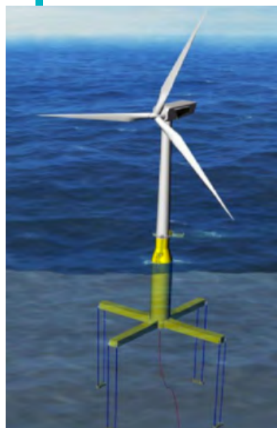
Ilustración 3. Simulación prototipo Plataforma TLPWind.
