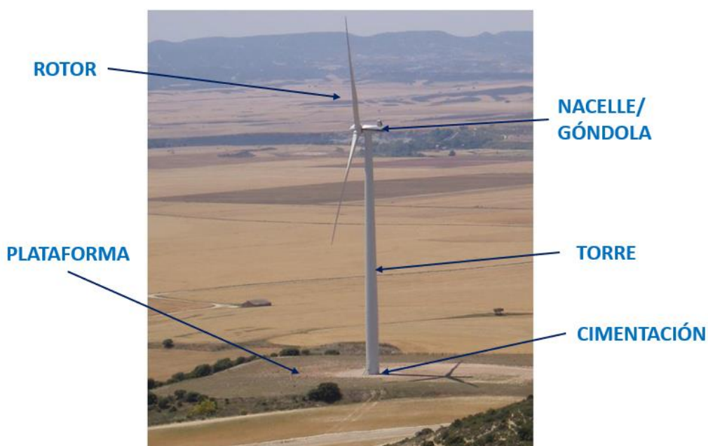
Figura 1: Principales partes de un aerogenerador.
