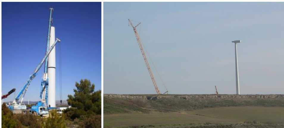
Figura 7. Montaje de torre de aerogenerador (izquierda) y aerogenerador con góndola montada (derecha).
