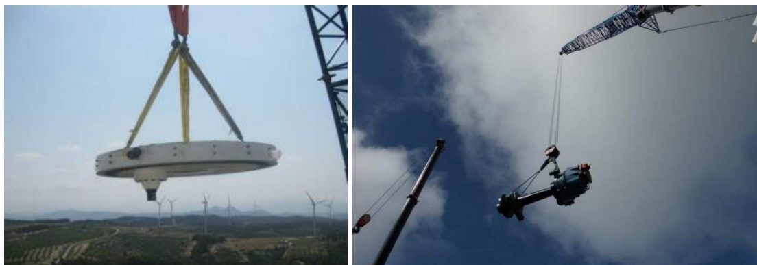
Figura 9. Sustitución de un rodamiento de pala (izquierda) y de eje principal (derecha).
