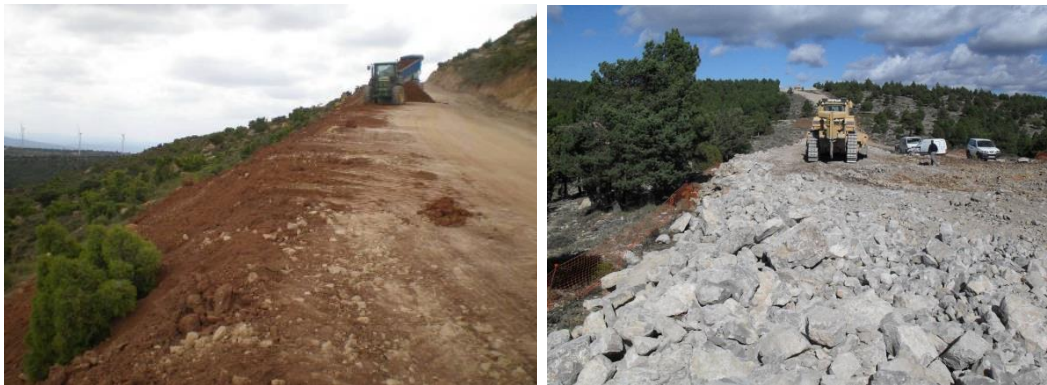
Figura 5. Trabajos de estabilización de taludes en los viales de un parque eólico.
