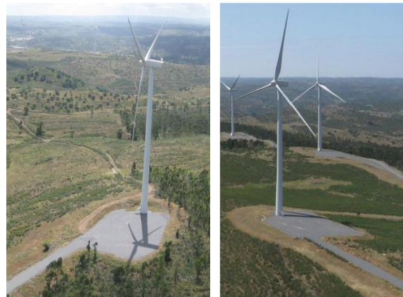
Figura 6. Plataformas de aerogeneradores, zonas contiguas a los aerogeneradores utilizadas para el acopio de los equipos del aerogenerador y para la situación de las grúas.
