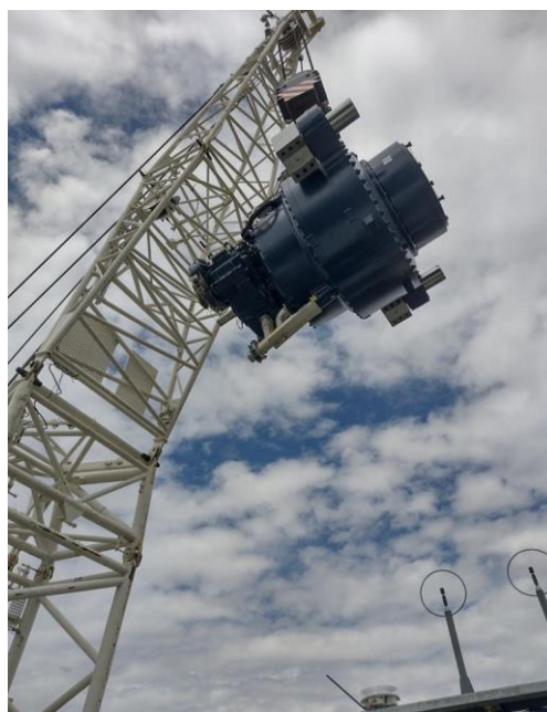
Figura 8. Sustitución de multiplicadora.
