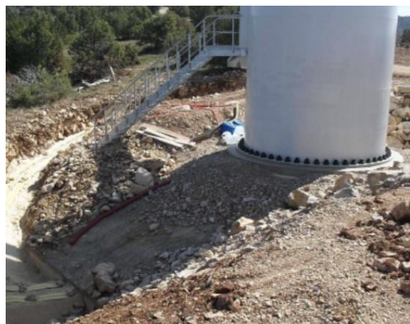
Figura 3. Trabajos en cimentaciones de un aerogenerador.
