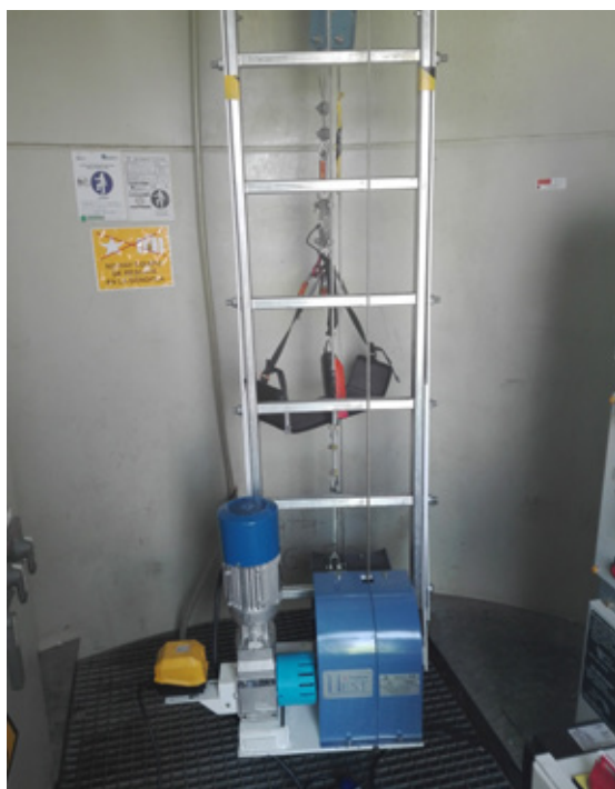
FIGURA 2 Sistema portátil de elevación para el interior de los aerogeneradores. N.E.S.T. de TAMOIN.
