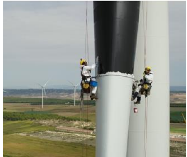
Figura 1: Vinilado de torre de aerogenerador con ojos (izquierda) y pintado de negro de una pala (derecha) (Fuente: Energías Renovables).
