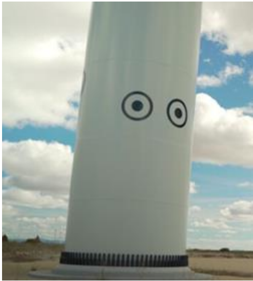
Figura 1: Vinilado de torre de aerogenerador con ojos (izquierda) y pintado de negro de una pala (derecha) (Fuente: Energías Renovables).
