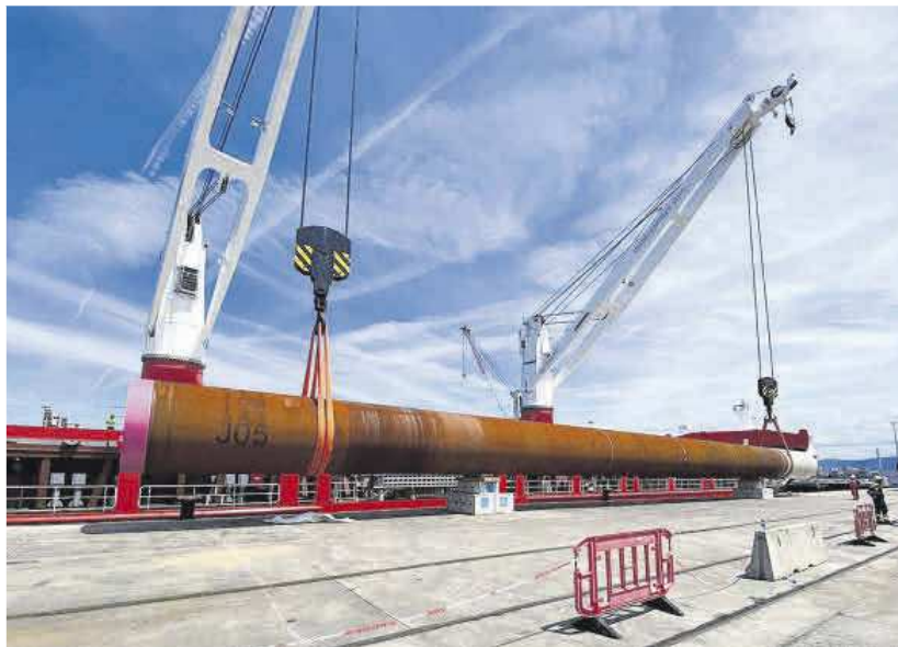
Carga de uno de los pin piles de Windar en el buque «Ronnie», en la octava alineación de los muelles de La Osa, esta semana.
