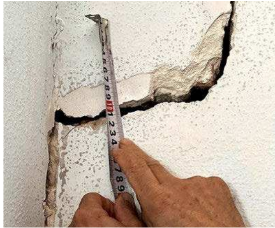
La imagen muestra las dimensiones de una de las grietas. / DIPUTACIÓN DE ALBACETE
