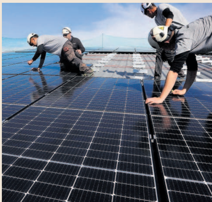
Montaje de estructuras de placas solares en un tejado. CRISTÓBAL CASTRO
