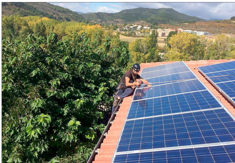
Instalación de placas solares para autoconsumo en una vivienda. ICAL
