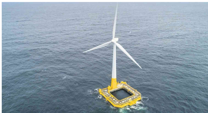
LOS AEROGENERADORES SE INSTALAN SOBRE FLOTADORES Y VAN AMARRADOS AL FONDO MARINO MEDIANTE CABLES. DA
