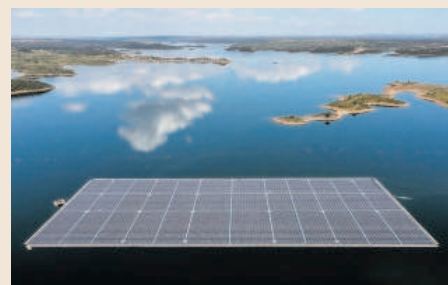
Una instalación fotovoltaica flotante, en el embalse del Alqueva (Portugal). CEDIDA POR EDP
