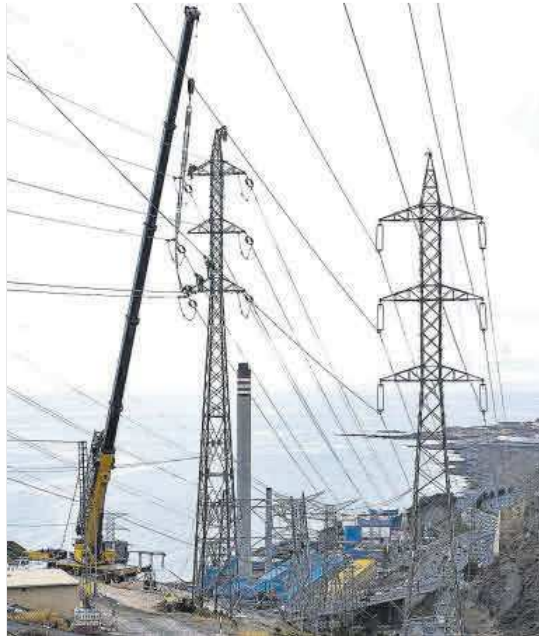
Operarios desmontan torretas de alta tensión. | ANDRÉS CRUZ
