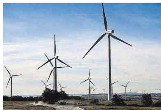
Parque eólico en el municipio de Veciana, en Barcelona.
