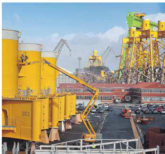
Estructuras de eólica marina en Navantia Fene. JOSÉ PARDO
